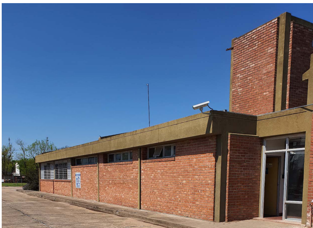
Edificio de Control
