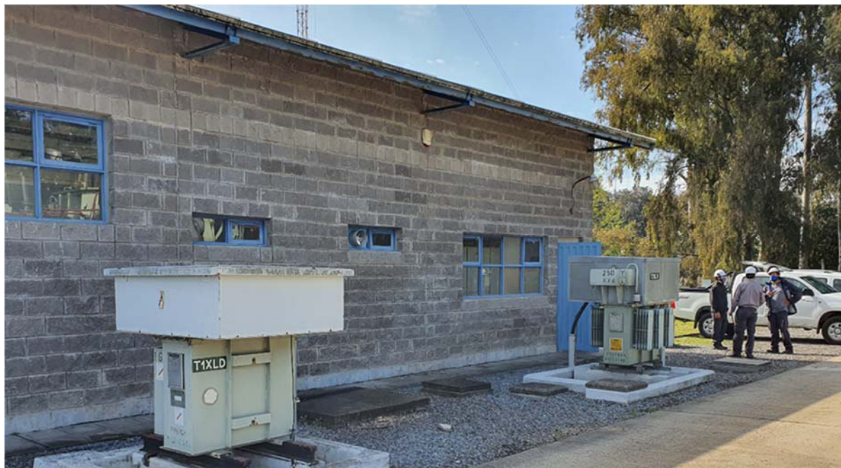
Edificio de Control
