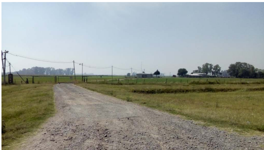
Calle rural con líneas de MT
