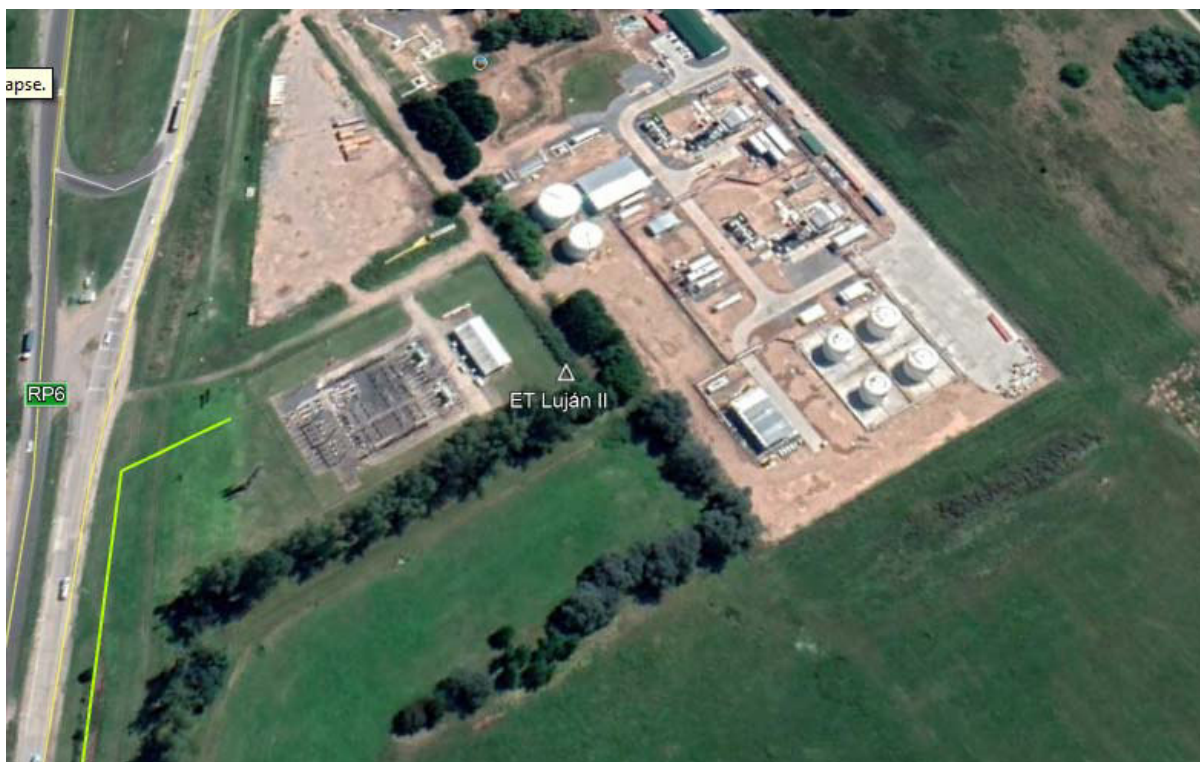
Vista aérea. Zona de ampliación y cortina de árboles a eliminar
